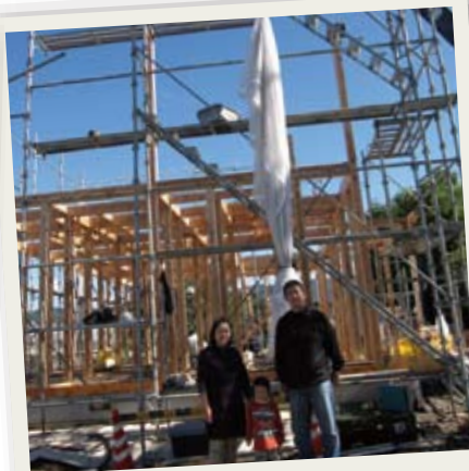
11月1日 M様邸 建前 長期優良住宅、2棟目
