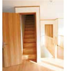
小屋裏収納へ向かう階段にはドアを設置し、断熱を強化
